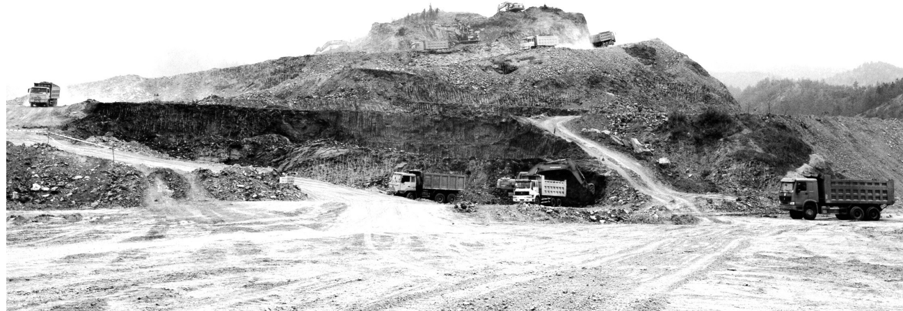
2000余个。目前,该项目一期工程已开挖土石方100万方,场平180亩,完成投资近
