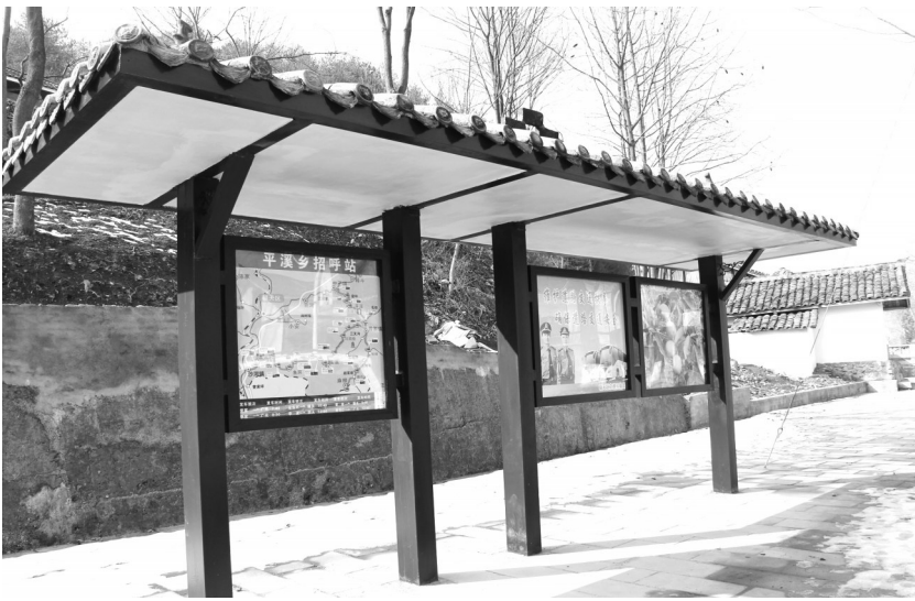
已建成的平溪招呼站。
