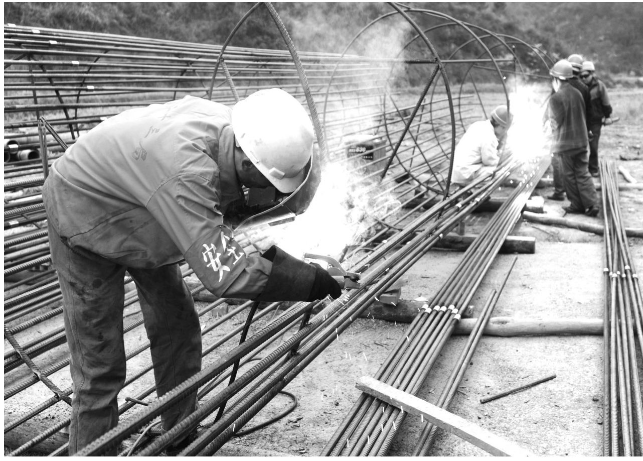
工人正在焊接坑桩。
