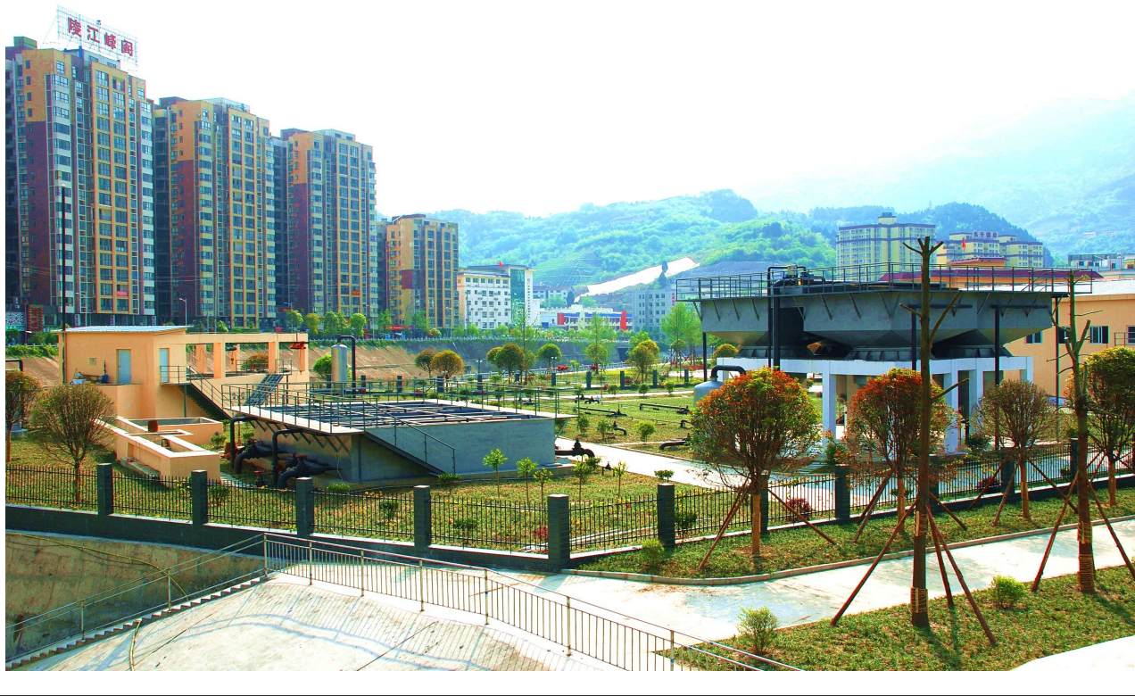
朝天区小中坝污水处理厂一角。
