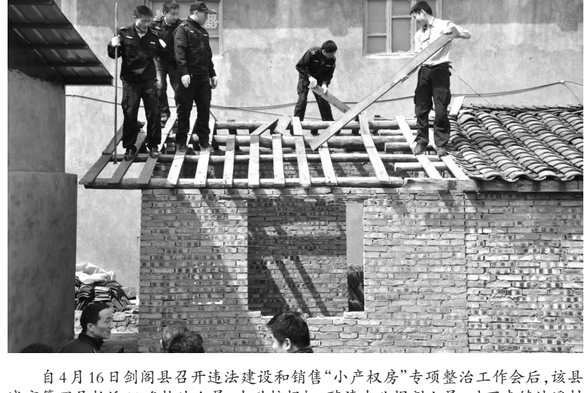
自4月16日剑阁县召开违法建设和销售“小产权房”专项整治工作会后,该县城市管理局抽派30名执法人员,出动挖掘机,聘请专业焊割人员,对下寺镇沙漠村二组、三组六处345平方米违章建筑进行依法强制拆除。梁杰 姚佳 摄
