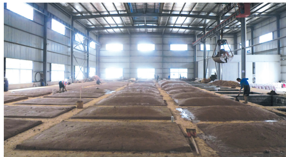
工人正在全力敷窖泥。
