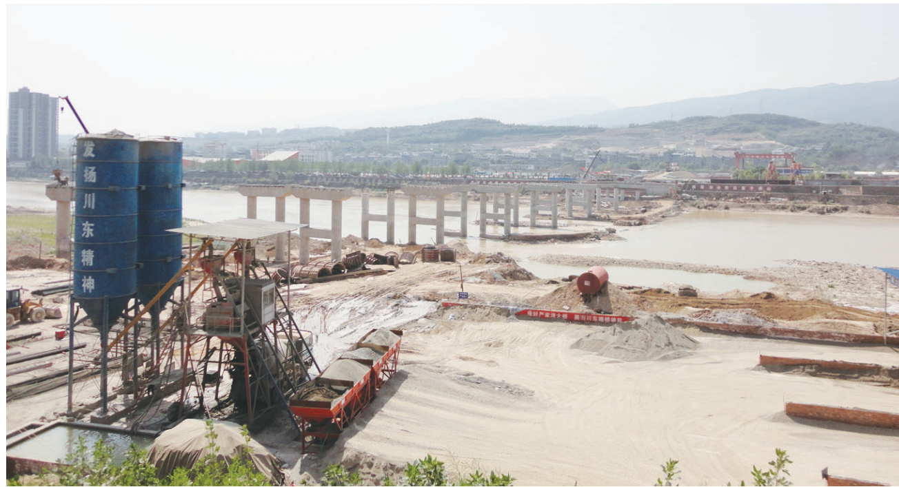
热火朝天的严家湾嘉陵江大桥施工现场
