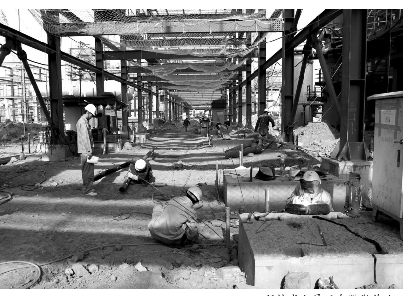
工程技术人员正在紧张作业。
