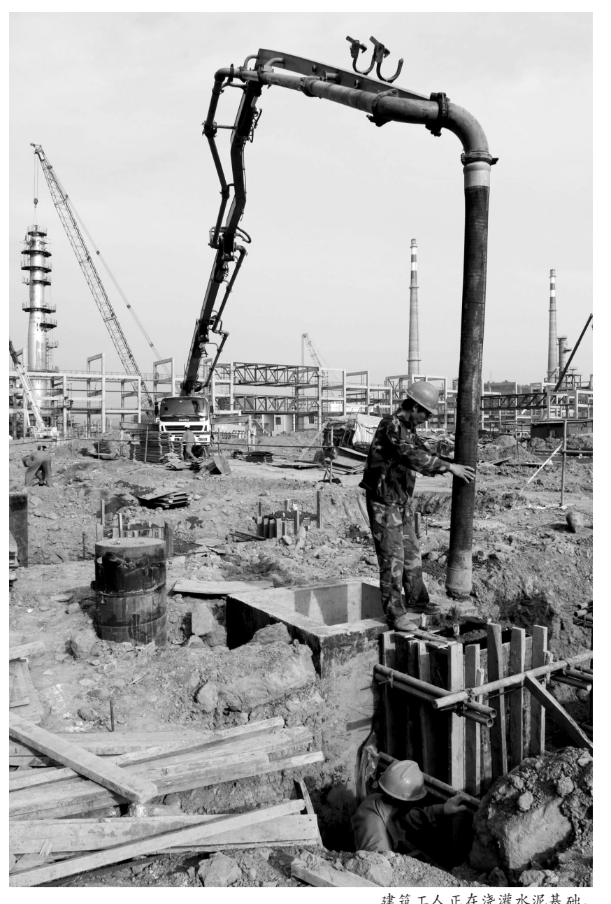
建筑工人正在浇灌水泥基础。
