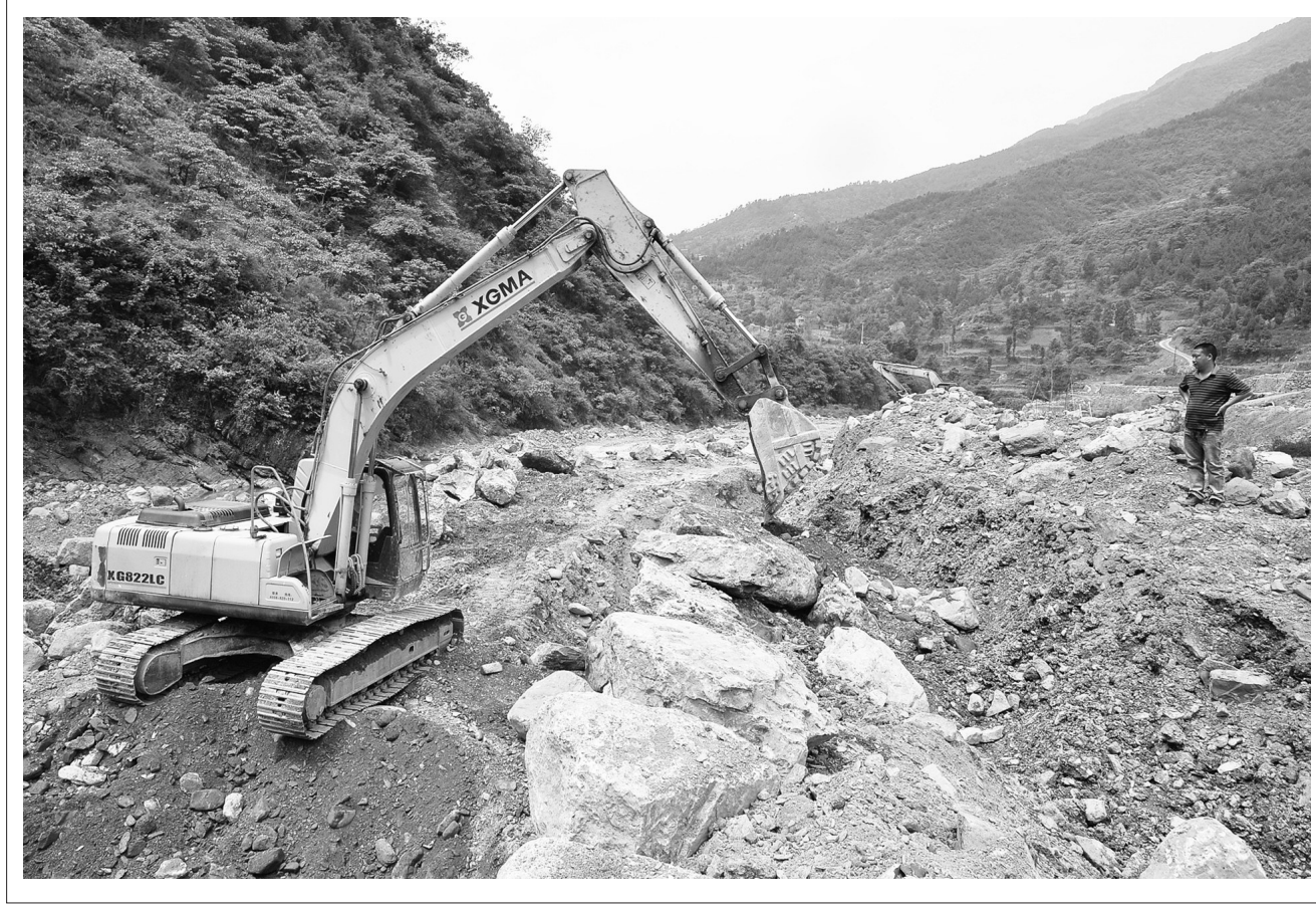
连日来,利州区结合汛期实际,采取狠抓河道治理整治,加强物资储备等措施确保全区安全平稳度汛。截至目前,该区新开工建设堤防3处,清理河道3处,排查整改安全隐患20余处,新建水位站25处、简易雨量站和预警广播站77处。图为6月17日,利州区三堆镇清理河道现场。 本报记者 张玉洁 摄
