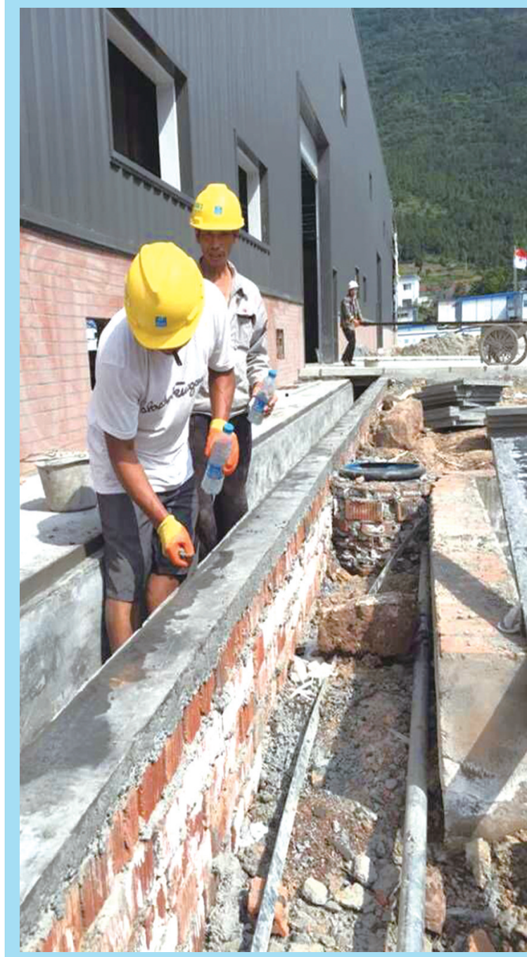
新纪元项目工人在浇筑水泥槽沟
