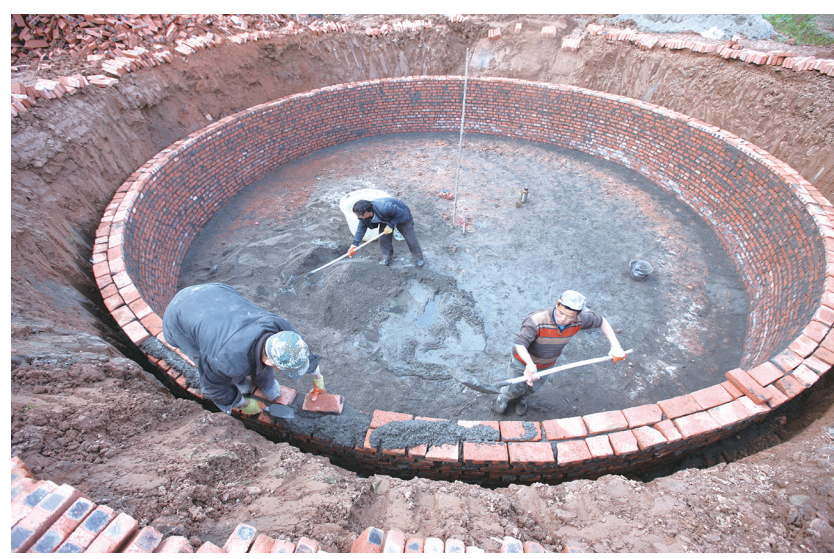
2016年旺苍县整合投资1710多万元在23个贫困村、67个非贫困村建饮水安全工程679处,解决2万人的饮水困难;在23个贫困村中的15个村整治险山坪塘7口、建防渗渠道19.3公里、新建蓄水池78口。图为1月10日,该县化龙乡石川村正在修建蓄水池。
