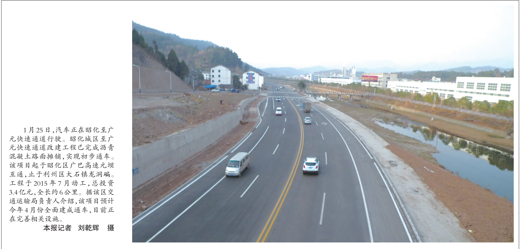
1月25日,汽车正在昭化至广元快速通道行驶。昭化城区至广元快速通道改建工程已完成沥青混凝土路面摊铺,实现初步通车。该项目起于昭化区广巴高速元坝互通,止于利州区大石镇龙洞洞。工程于2015年7月动工,总投资3.4亿元,全长约6公里。据该区交通运输局负责人介绍,该项目预计今年4月份全面建成通车,目前正在完善相关设施。
