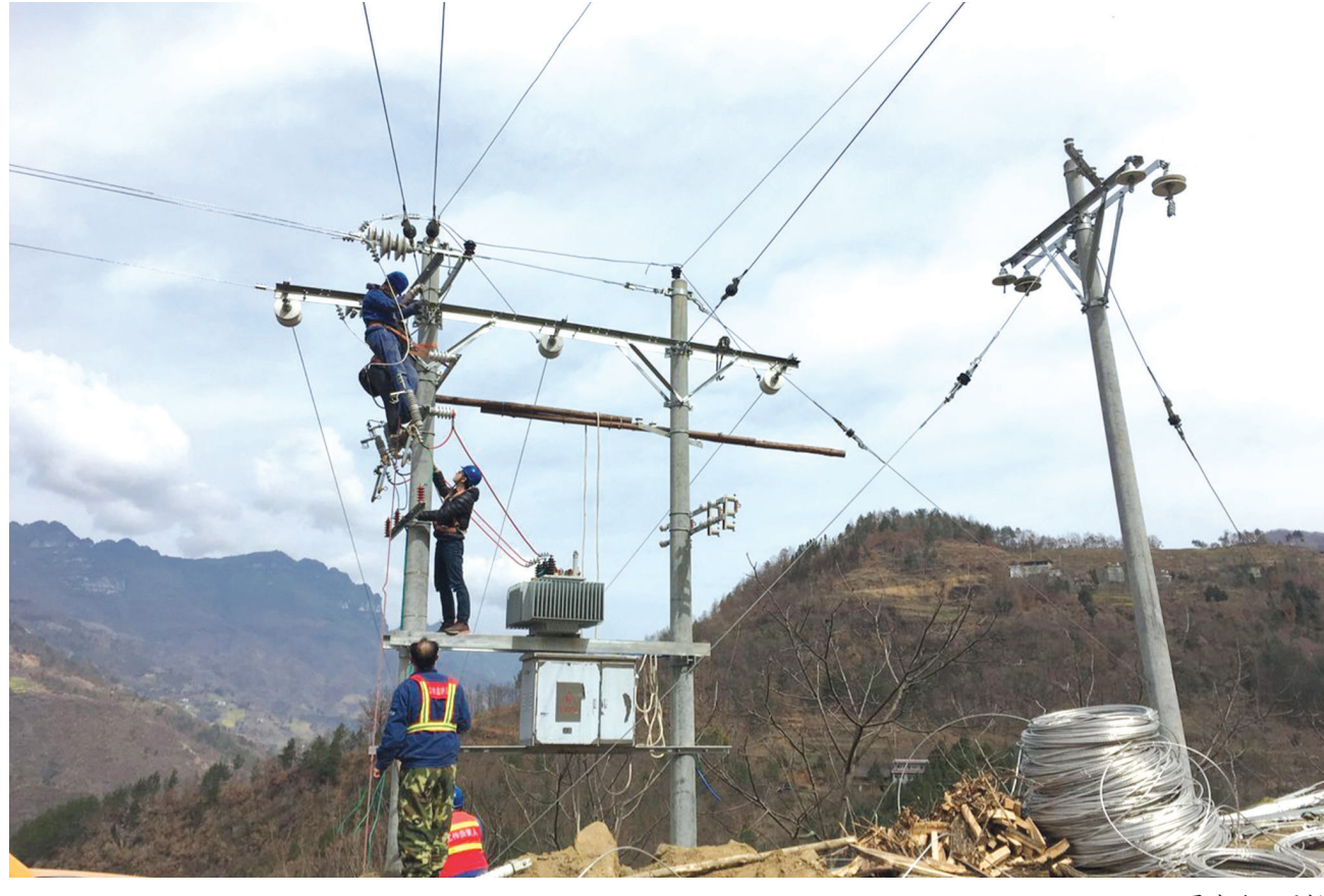
图为施工现场
