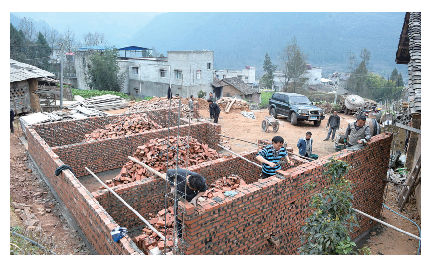
凤阳村危旧房改造施工现场。
