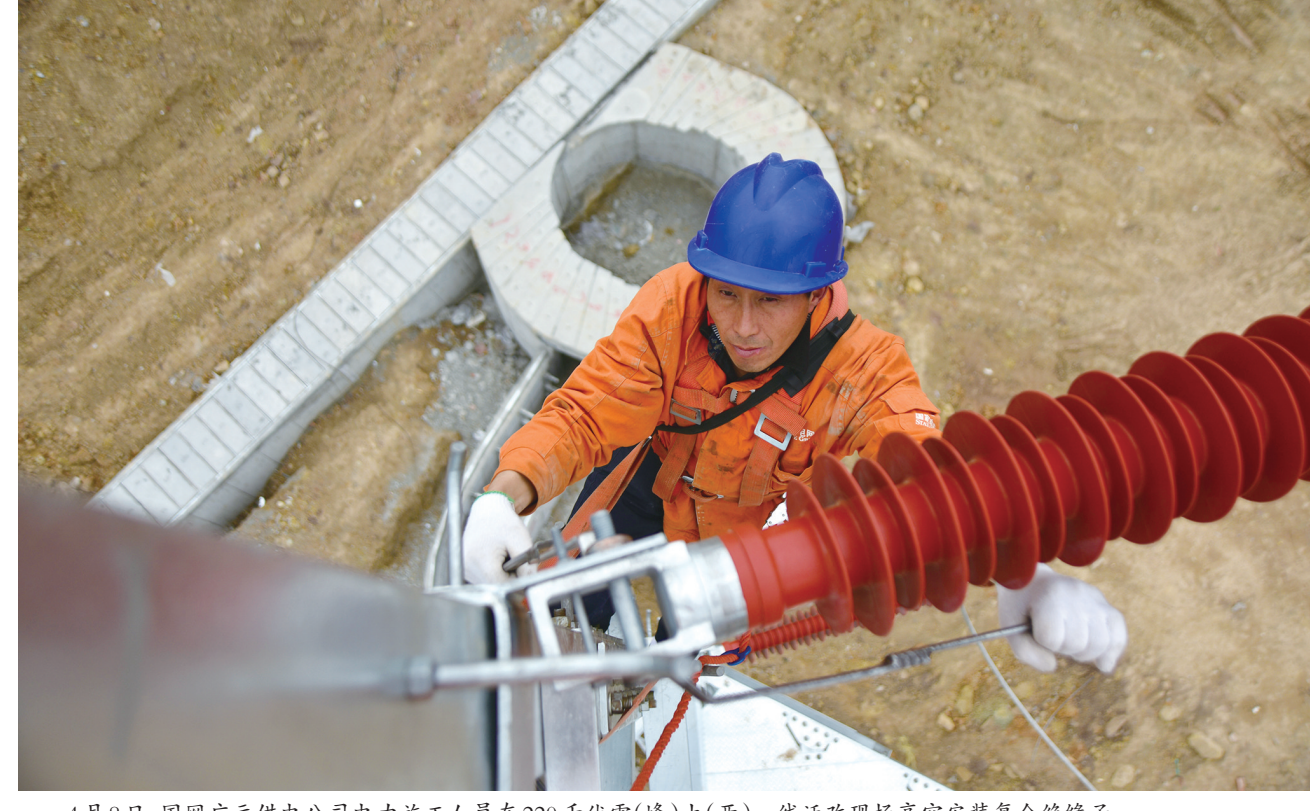
4月8日,国网广元供电公司电力施工人员在220千伏雪(峰)上(西)一线迁改现场高空安装复合绝缘子。为确保西成客专建设的顺利推进,国网广元供电公司主动配合铁路施工单位,全力以赴投入到220千伏雪(峰)上(西)一线电力铁塔迁改施工重建任务,积极助力重大项目工程建设。张超 摄
