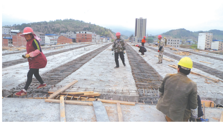
▲记者4月7日拍摄的正在建设的南河8号桥。
