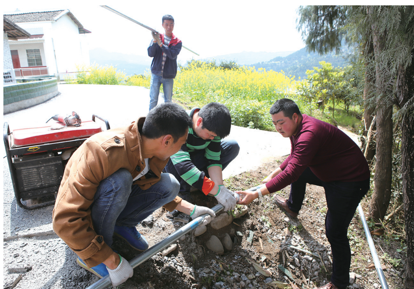
工人在张华镇松浪村安装人饮水管。
