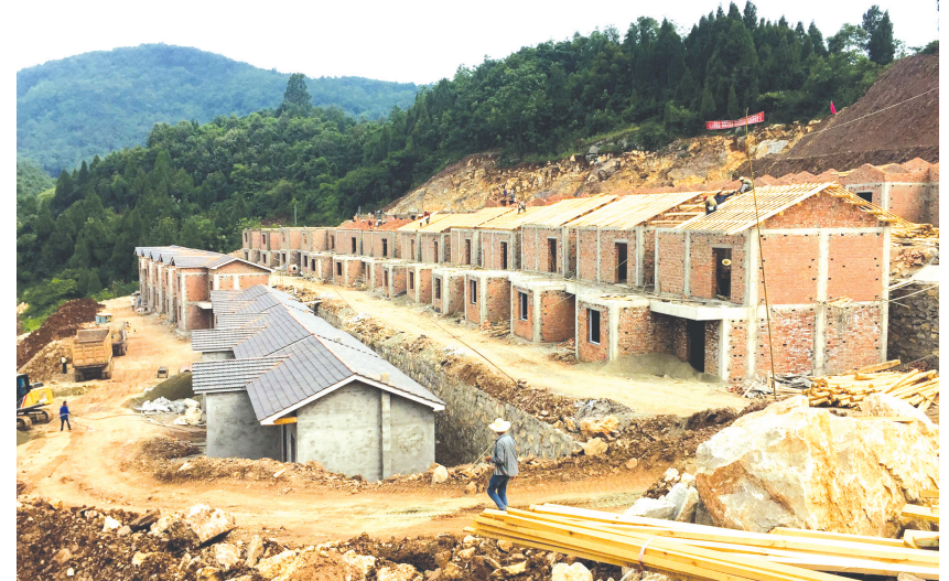
建设中的罗圈岩村易地扶贫搬迁集中安置点。
