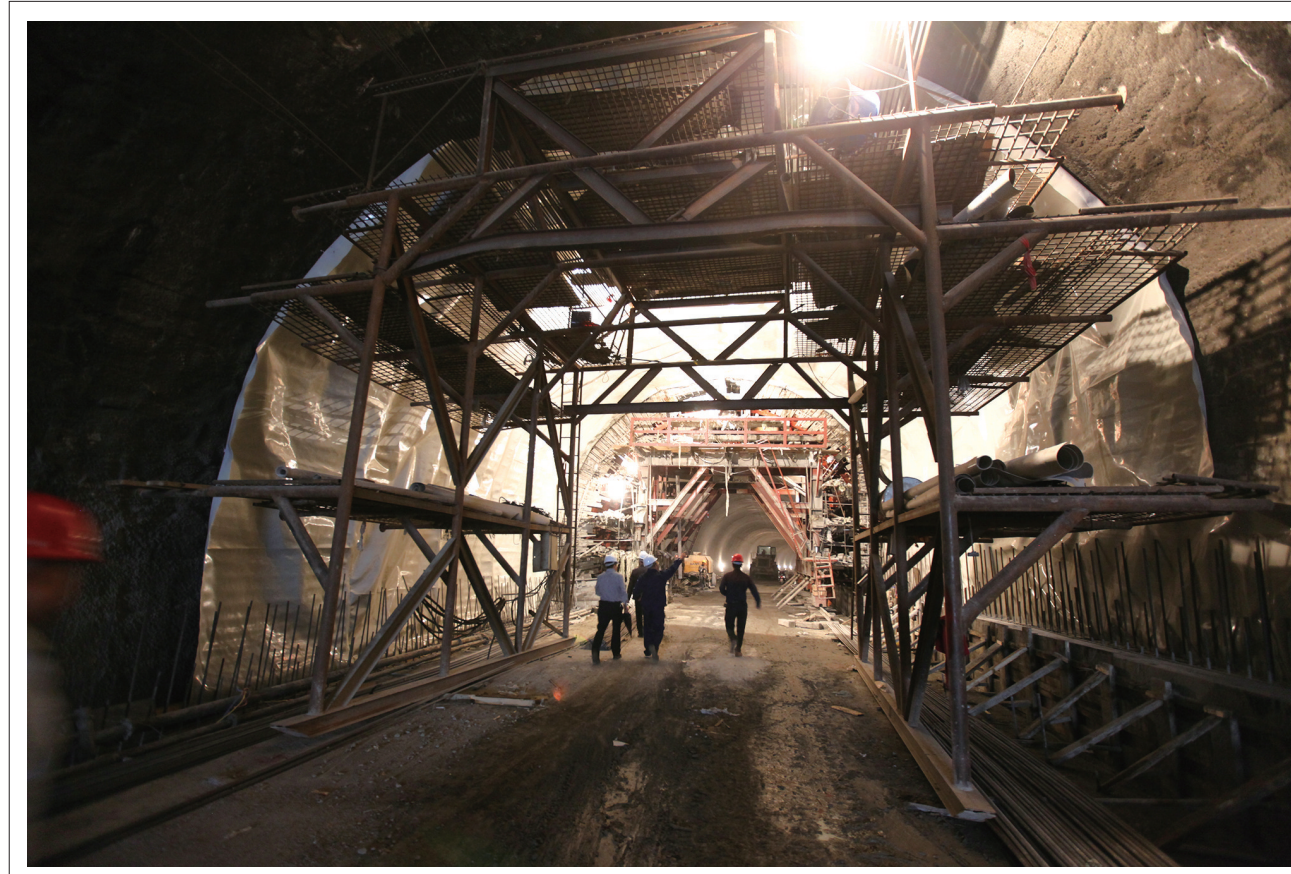
国道108线严家湾隧道工程起于电子路北延线二段,设严家湾隧道穿越嘉陵江左岸山脊,止于在建的国道108线严家湾嘉陵江大桥1#桥墩。线路全长1066米,路基宽23米,设计时速60公里,按一级公路标准建设。该项目已于2016年1月14日开工建设,计划年底隧道右洞全面贯通,2018年4月完成隧道所有附属设施工程,预计5月通车。
