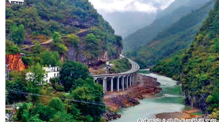
在建旺宁公路仰天洞桥梁工程
