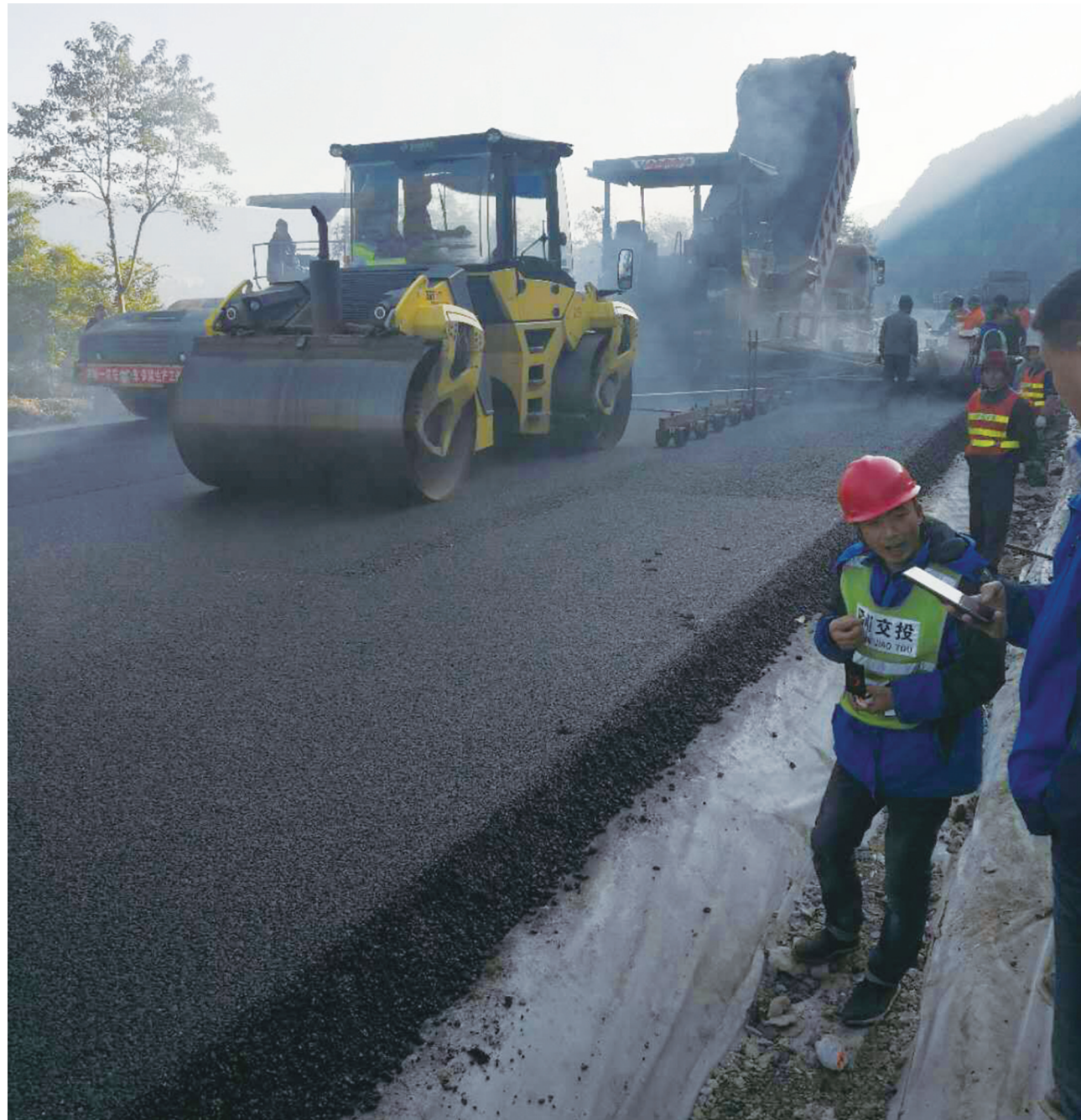
2018年1月11日,鸭浮岩至纺织大道改建工程正在铺筑沥青。国道108线鸭浮岩至纺织大道段公路改建工程属于国道108线瓷窑铺至沙溪坝公路改建工程其中一段...
