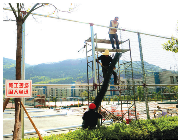
施工人员正在安装网球场围网
