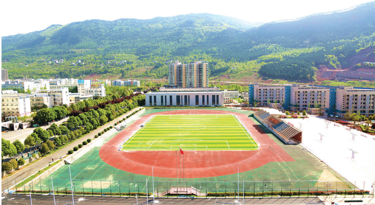
足球场改造现场
