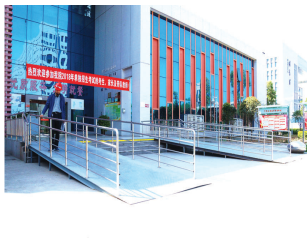
施工人员检验学校食堂处的无障碍设施
