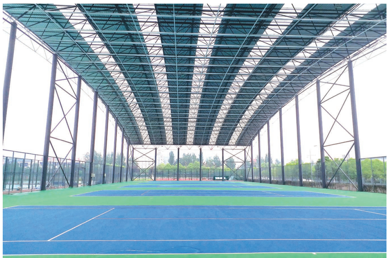
8日,维修改造后的网球场。据悉,澳体中心网球场维修改造项目,已于3月底全面完工。该网球场面积为3788平方米,主要对5片室外网球场进行了钢结构加盖,增设了比赛灯光、观众坐席,采用的丙烯酸等主要材料已通过国家专业环保检测机构的检测,并达到国家环保标准。
