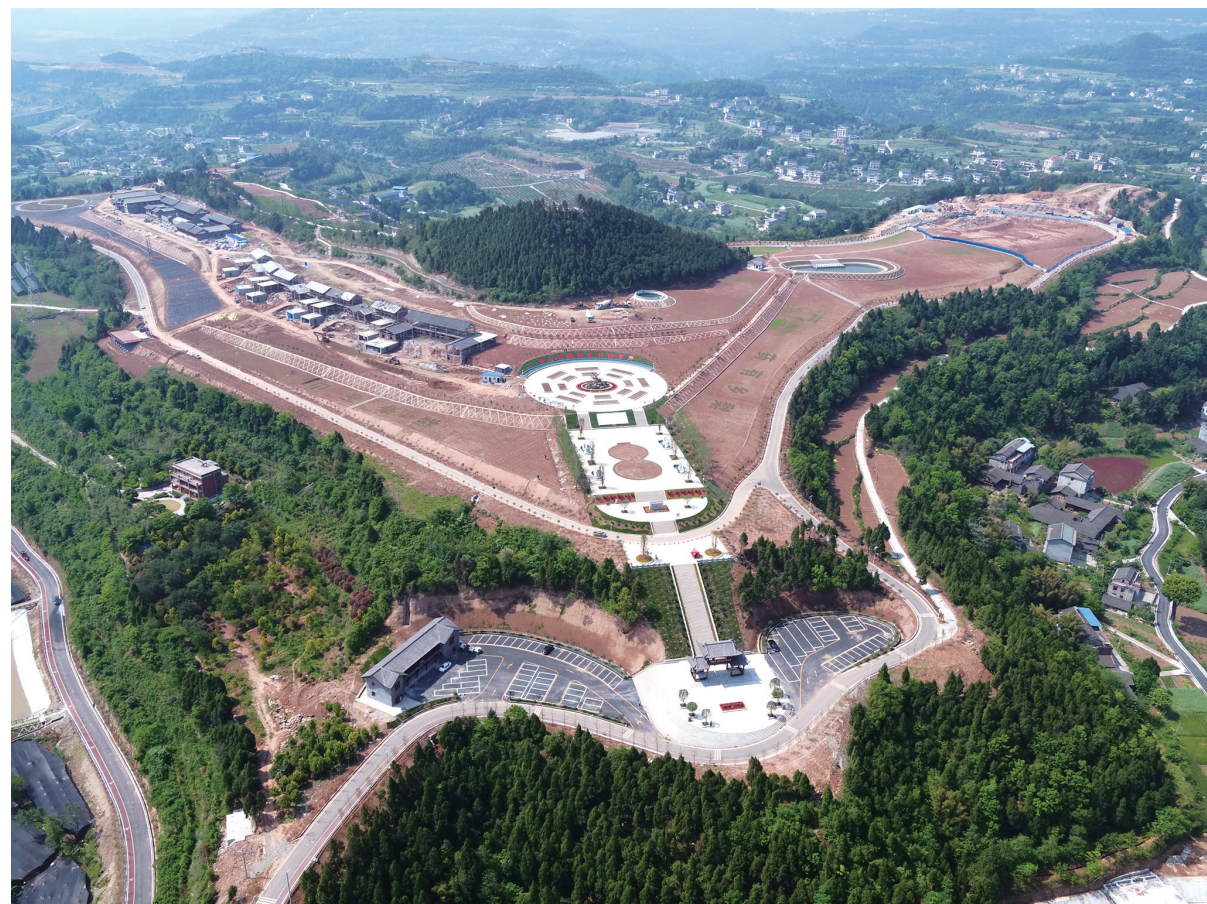
正在建设中的苍溪农博园。
