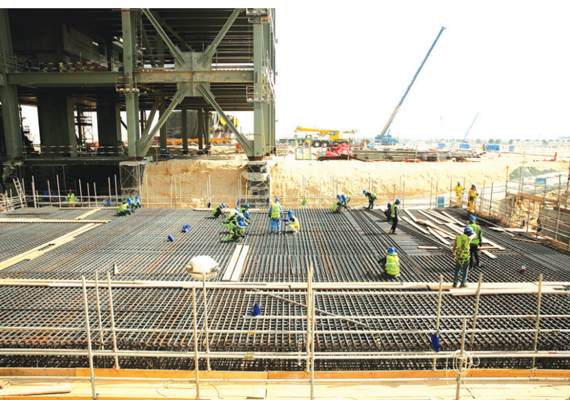
这是6月27日在阿联酋迪拜拍摄的哈翔清洁燃煤电站施工现场。在阿联酋迪拜以南30多公里的海边,迪拜哈翔清洁燃煤电站正在施工,这是建设中的中东地区首座清洁燃煤电站,也是“一带一路”框架下中东地区首个中资企业参与投资、建设和运营的电站项目。 新华社发(张春明摄)
