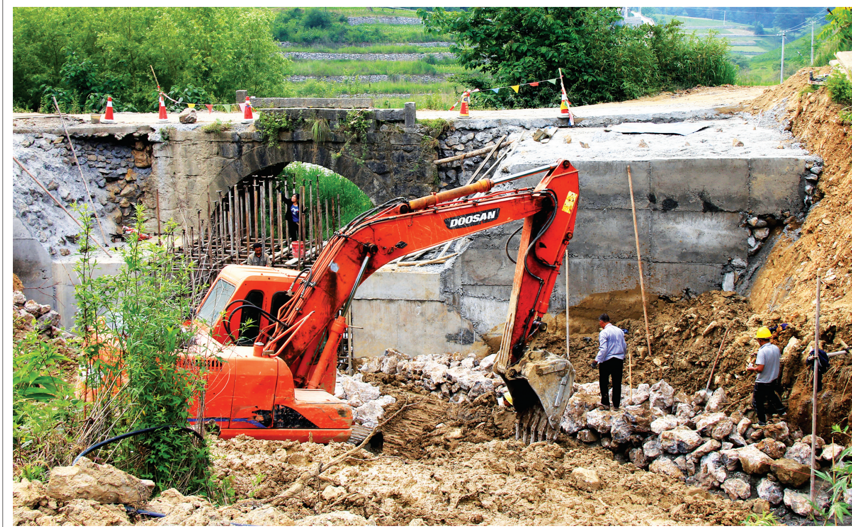
今年以来,朝天区以脱贫摘帽为统领,深入开展“四好村”创建,大力实施“六化行动”,全力推进53个贫困村的新农村建设,以及150个非贫困村贫困户和11个已实施过新村建设的贫困村贫困户的相关户办工程建设。目前,新村建设的各项工作快速有效推进,53个贫困村的新农村建设已完成规划任务的89.2%;150个非贫困村贫困户和11个已实施过新村建设的贫困村贫困户的相关户办工程建设已完成规划任务的92.9%。图为朝天区两河口乡黄柏村新村建设现场。王泽东 摄
