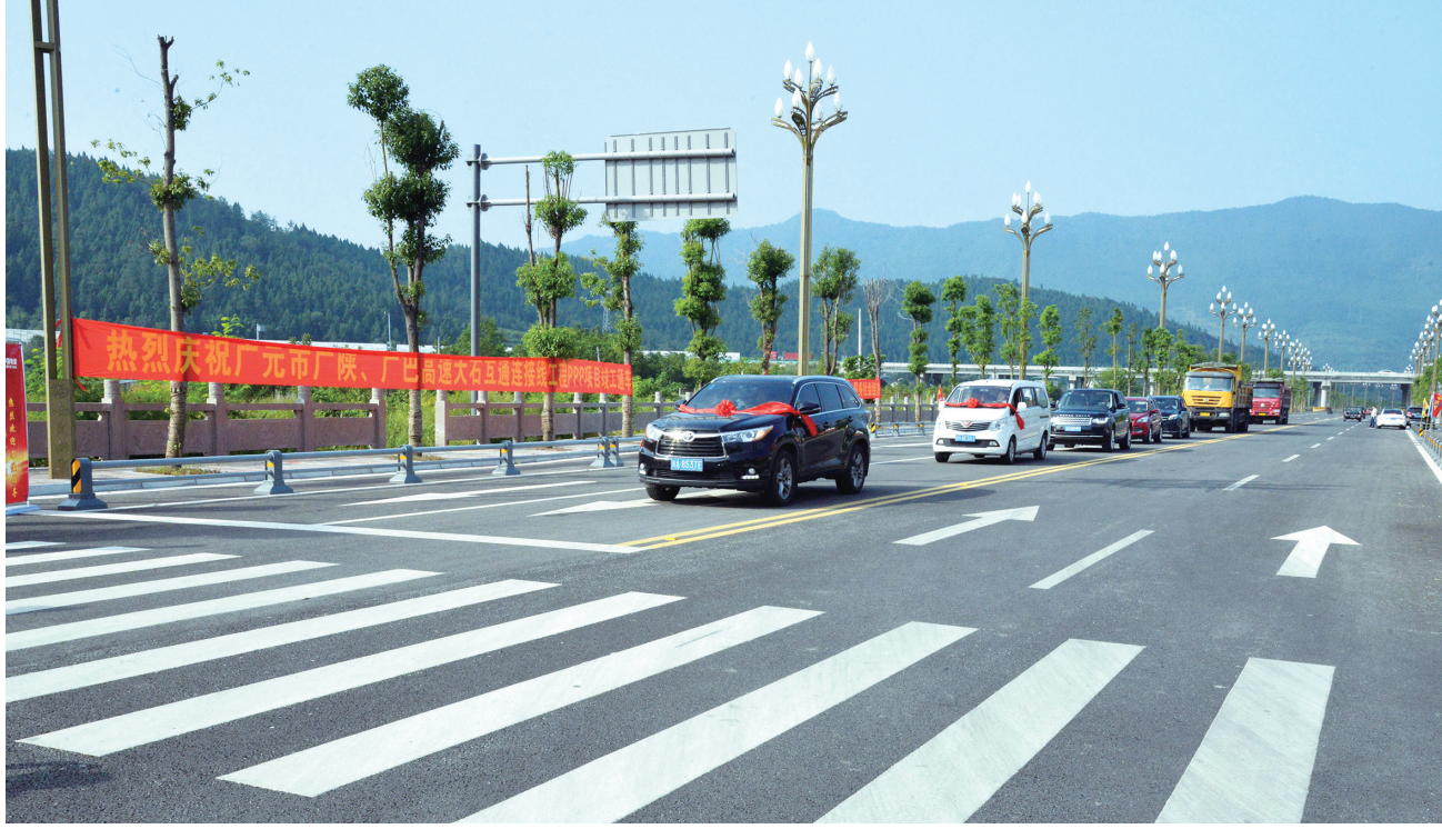
广陕广巴高速大石互通连接线工程正式竣工通车。
