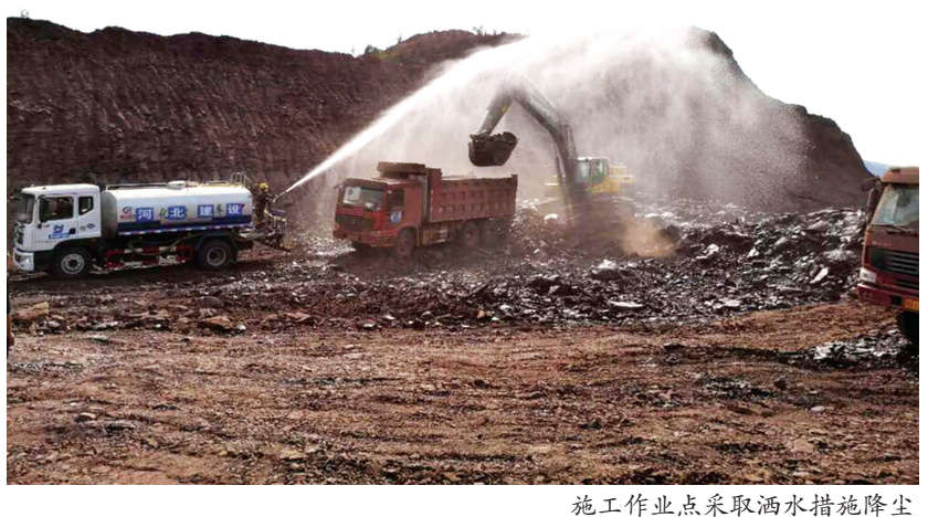
施工作业点采取洒水措施降尘
