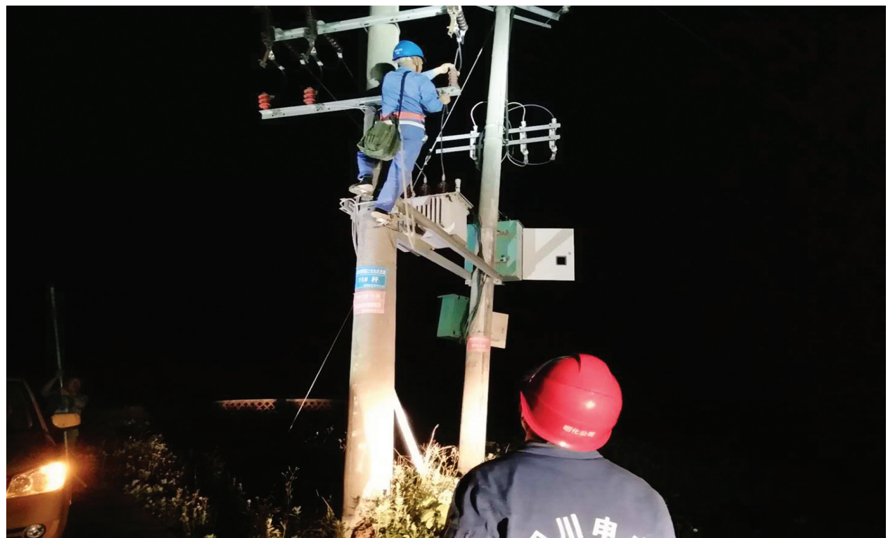
电力行业,昭化电力公司节日深夜为虎跳镇三公村九社更换避雷器。
