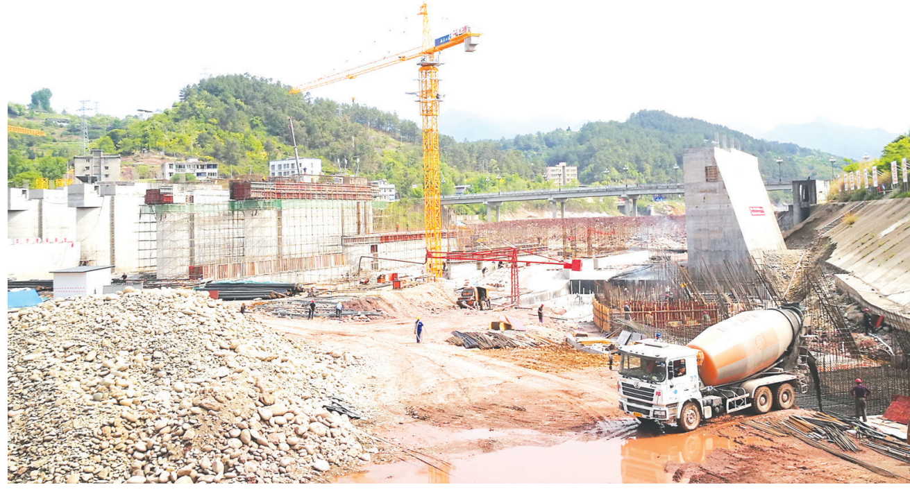
总投资7.6亿元的旺苍县城区河道综合整治工程(一期)PPP项目,分别位于旺苍县东河镇和嘉川镇。该项目包括两级拦河坝(旺月坝、石龙坝),闸坝廊桥、栈道及其安全防护工程。闸坝廊桥工程利用闸室上闸墩布置风雨廊桥,廊桥采用框架结构,风格为仿古建筑,沿河新建栈道采用水泥仿木栈道,总长1.43公里。该项目2017年12月16日开工建设,目前已基本完成工程的闸室混凝土浇筑,预计2020年5月建成投入使用。该项目集水利、交通、休闲、景观等功能于一体,建成后,对改善城市水生态环境,维护县城河床稳定和堤防工程安全具有重要作用。
