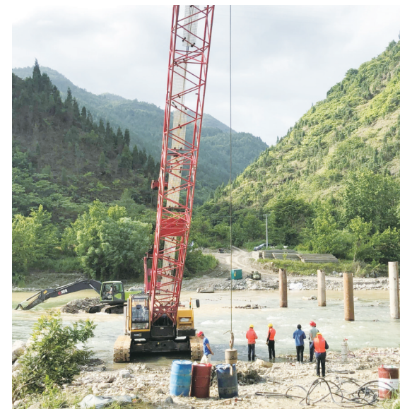
S410线钢栈桥施工现场
