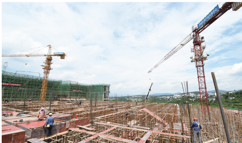
图为建设现场 梁举川 本报记者 刘怀英 摄
