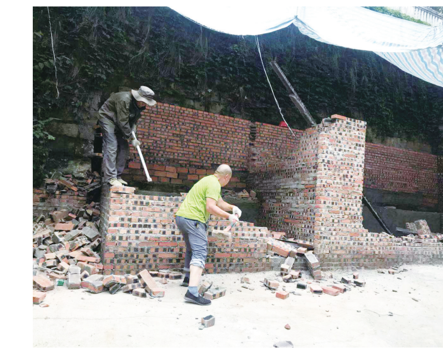
7月25日,利州区综合行政执法局东坝中队对新社区星光幼儿园违法搭建的建(构)筑物进行拆除。图为拆除现场。
