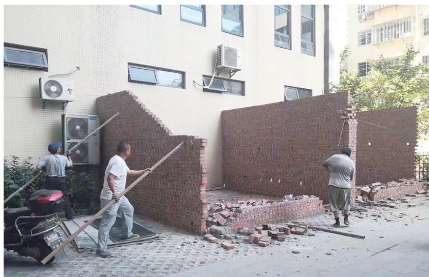
8月14日,利州区综合行政执法局嘉陵中队组织拆除翠江半岛院内的违法建设,面积约50平方米。图为拆除现场。 本报记者 涂媛媛 摄
