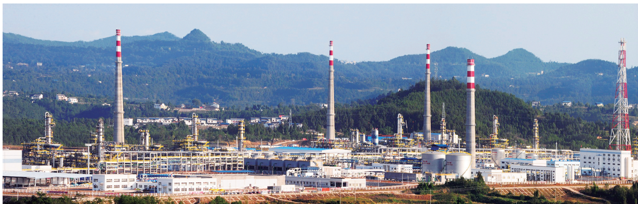
已建成投产的中石化元坝天然气净化厂(2015年6月8日摄)
