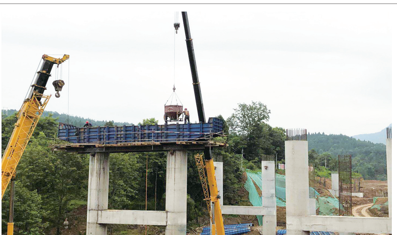
总投资4.6亿元的宝轮环线道路工程(南线)起于G108改线清江大桥南桥头与G108平交,向南北上跨规划道路,下穿西成客专,转向东穿越土地岭后,止于宝红互通立交,全线总长3.8公里,宽30米。项目建设包括罗家沟桥梁1座,杨家沟桥梁1座,土地岭隧道1座,隧道北洞长475米,南洞长425米。图为11月16日拍摄的正在建设的罗家沟桥梁。 赖锋 本报记者 刘怀英 摄
