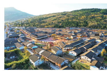
昭化西市项目全貌
