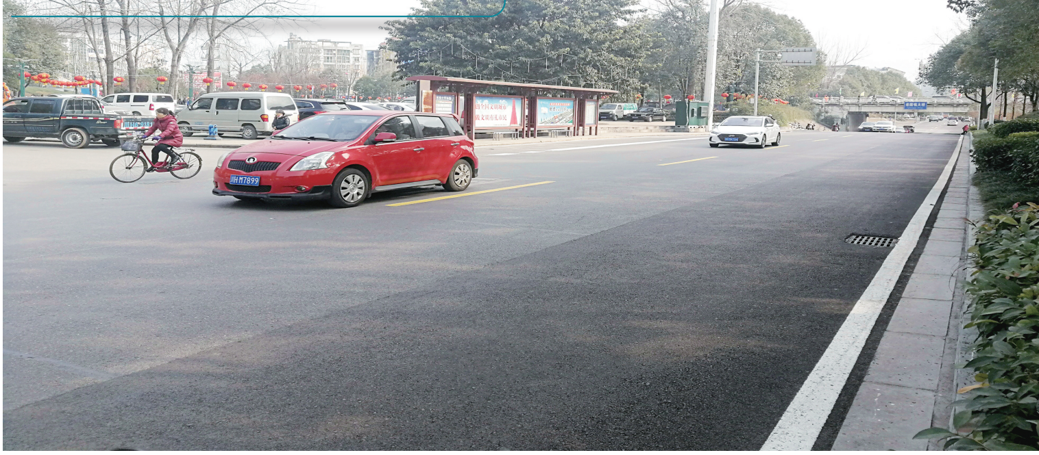
改造拓宽后的滨河北路
