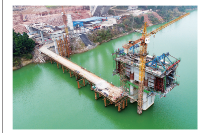
建设中的射箭镇邓家河大桥 市发改委供图
