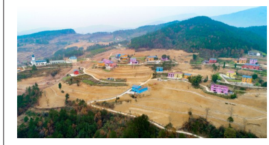
建设中的小寺山田园综合体项目 市发改委供图
