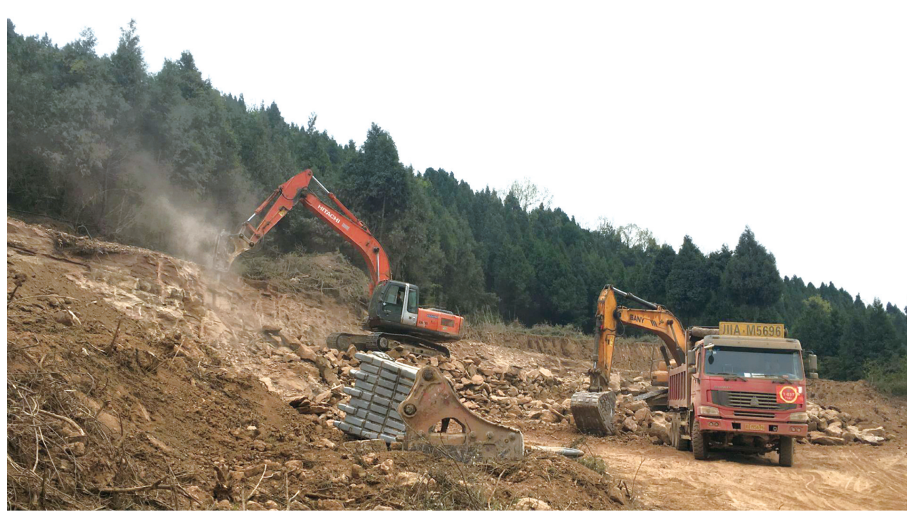
▲项目施工现场
