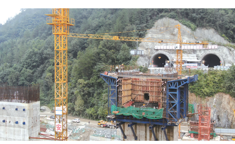
9月19日,二郎庙大桥左幅2#墩连续刚构0#块首件工程顺利完成浇筑。据了解,二郎庙大桥为广元高速公路控制性工程之一,左幅桥长607米,右幅桥长937米。
