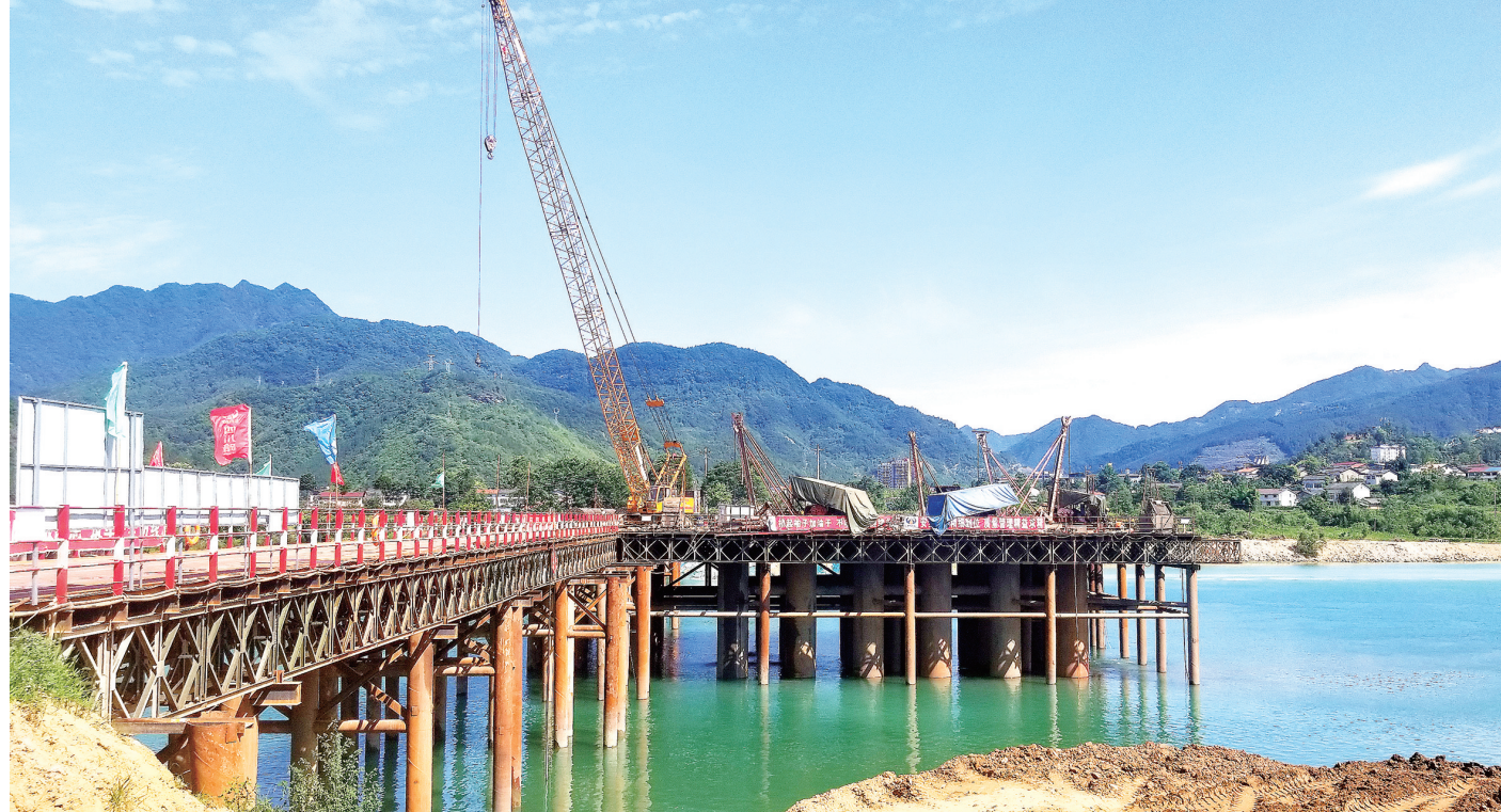
▲紫兰湖井田大桥建设项目推进有序。
