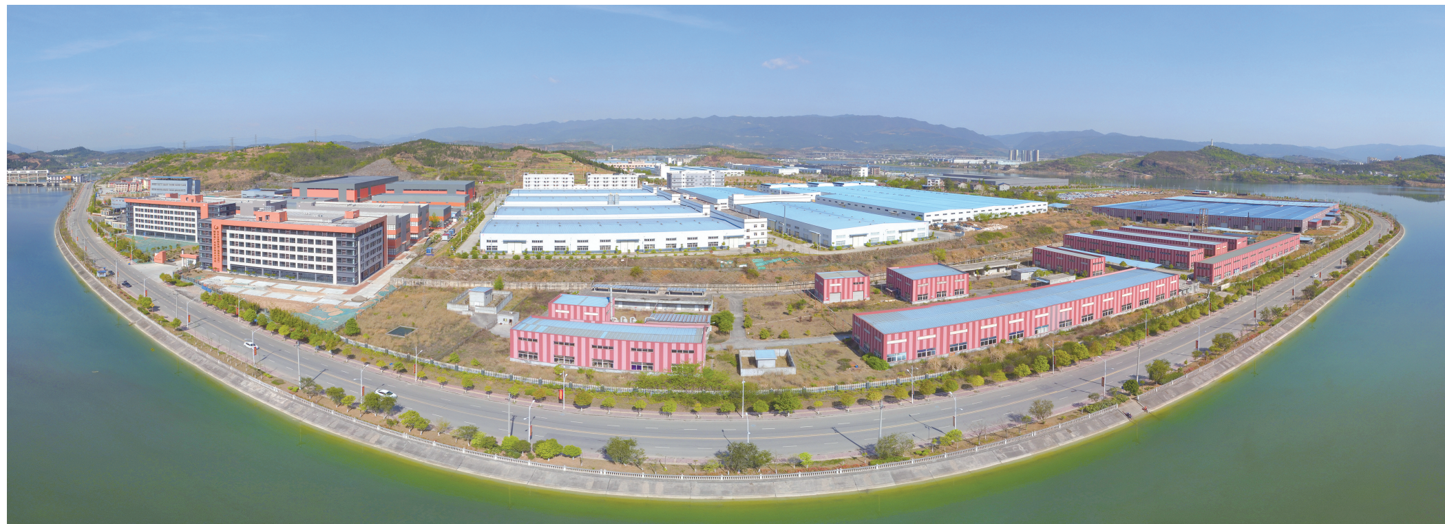
川浙产业园全貌
