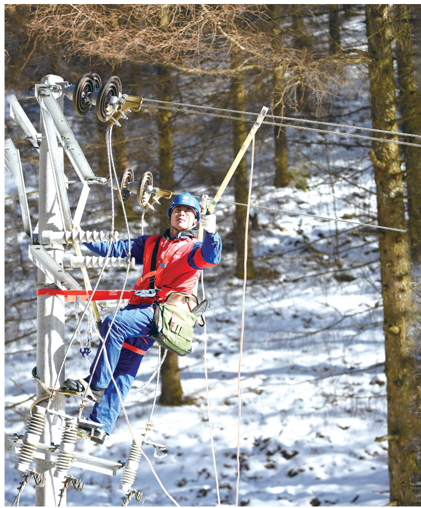
1月10日,朝天区曾家山李家林场被大雪覆盖,大雪在带来美景的同时,也给供电线路设备运维带来诸多挑战。为确保居民用电安全可靠,国网四川电力广元曾家供电所紧急抽调党员突击队对林区供电线路展开特巡。图为工作人员正在进行线路故障处理前的挂接地线操作。 蒋孟端 本报记者 孙汉 摄
