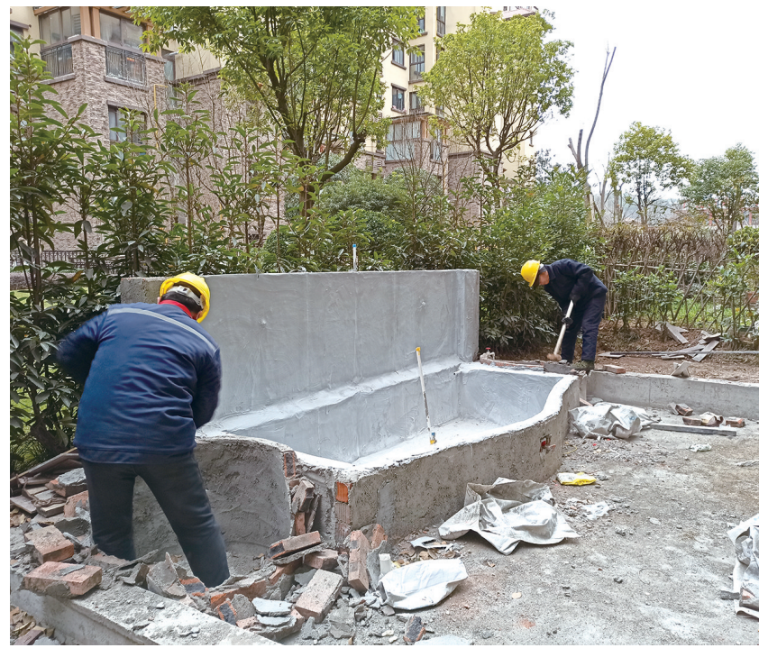
7日上午,利州区综合行政执法局东坝中队对东屏社区邦泰康郡小区13-1-102号搭建的违法建(构)筑物进行了强制拆除,面积约15㎡。图为拆除现场。 本报记者 赵雪洋 摄
