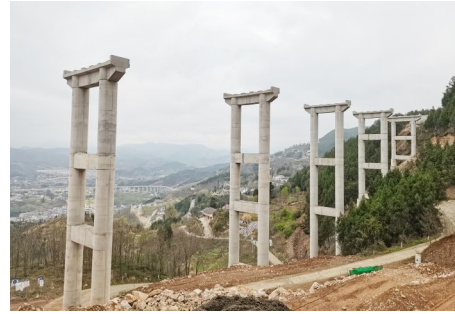
图为正在建设的七曾路青岩沟大桥。
