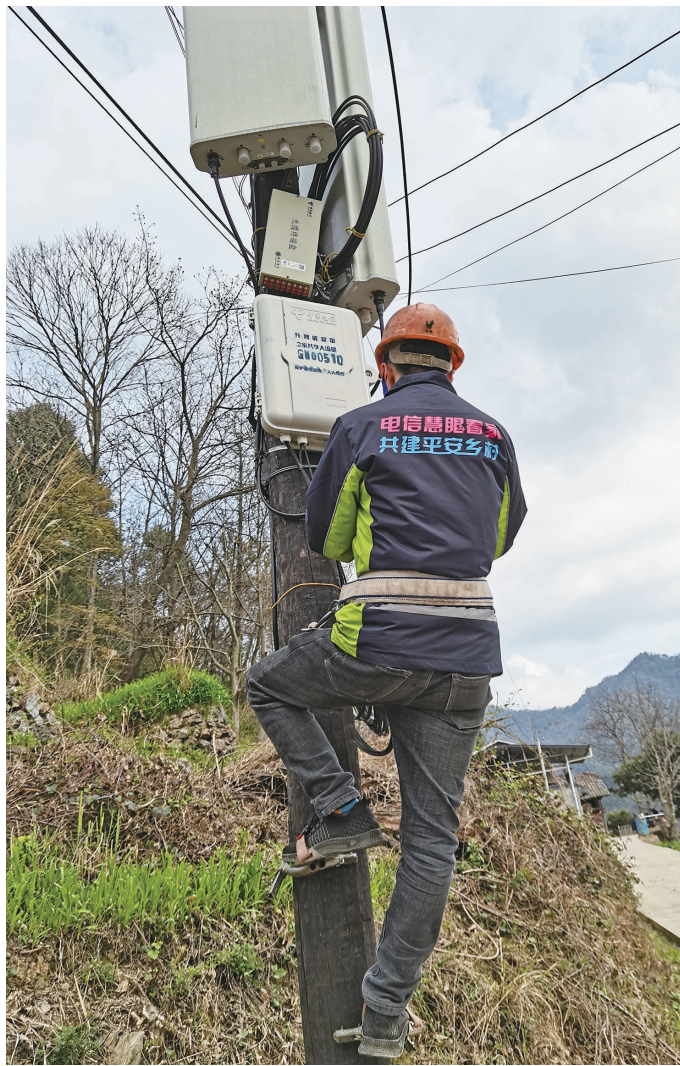
安装网络线路
