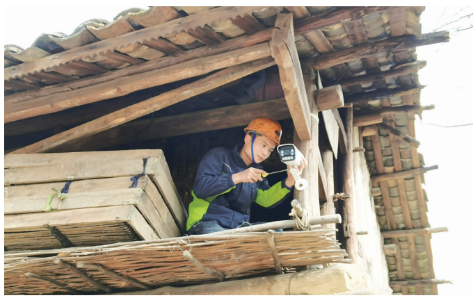
安装监控摄像头
