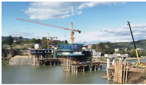
图为正在进行的第二联现浇箱梁施工。
