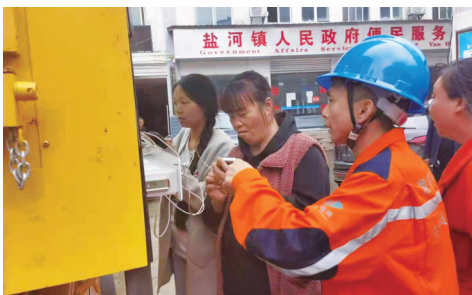
国网广元供电公司工作人员抢修电路
