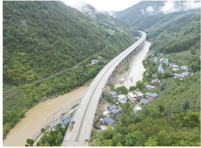
日前,位于青川县瓦砾村的广平高速公路柳河四号特大桥主体结构实现全线双幅贯通,为年底前实现20公里通车奠定了坚实基础。图为全线双幅贯通后的柳河四号特大桥。
