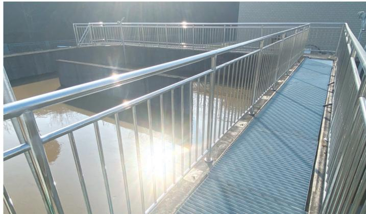
图为厌氧池一隅。此环节利用厌氧菌的作用,促使有机物分解,提高污水的可生化性。
