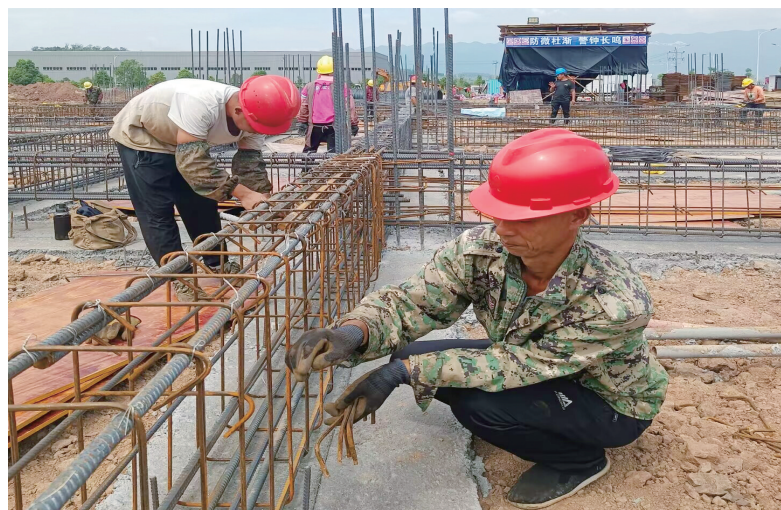
9月1日,广元经济技术开发区盘龙镇新龙村,广荣铝业年产10万吨铝精深加工项目施工现场,钢筋工师傅王志强正在进行绑地梁作业。王志强告诉记者,入秋后天气凉爽,正是抢抓工期的关键时刻,施工现场每天都有20名工友一同作业。据悉,该项目建设包含新建建材生产车间、棒材生产车间、铝板生产线及配套办公楼宿舍楼等附属设施,共计建筑面积164288平方米,购置60t矩形倾动式熔铝炉、熔体在线处理装置等设备。项目建成后可实现年收入16亿元,利税6900万元,解决就业850人。 截至目前,该项目综合楼基础承台等已完工,目前正进行地圈梁施工;厂房桩基等基础已完成,正在进行钢结构吊装。 广元日报全媒体记者 赵敬梅 摄
